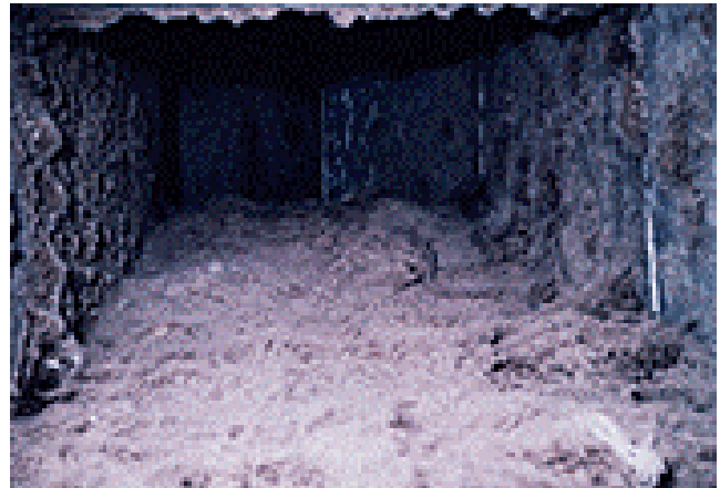
Kanal in Benutzung (es kann passieren, dass der Schimmel den Kanal fast ganz verstopft)
